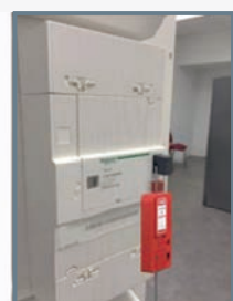
Orifício de \phi 2 mm para configurar o bloqueio
